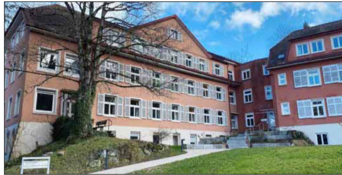
Im Johanneshaus der Klinik soll die neue Tagesklinik mit 18 Plätzen entstehen. Ein wichtiges Angebot, das eine Versorgungslücke im Dreisamtal und im Hochschwarzwald schließen kann.
